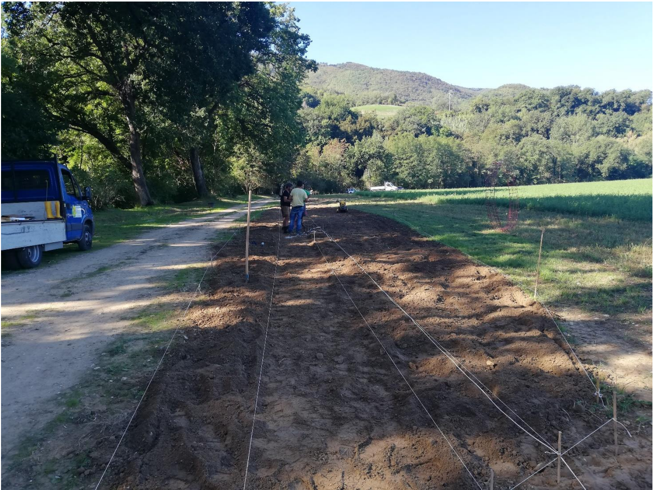
Esempio giardino sensoriale in fase di cantiere a Terre di Raffaello
